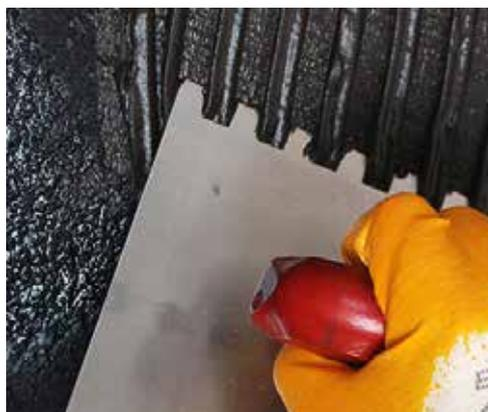
\*Zum Erreichen der geforderten mind. Trockenschichtstärke müssen die empfohlenen Nassschichtdicken des verwendeten Produktes in mind. 2 Lagen aufgebracht werden. Gemäß DIN 18533 ist zum Ausgleich von Untergrundunebenheiten und handwerklichen Schwankungen eine Kratzspachtelung aufzubringen. Des Weiteren sollte ein Schichtdickenzuschlag berücksichtigt werden!
