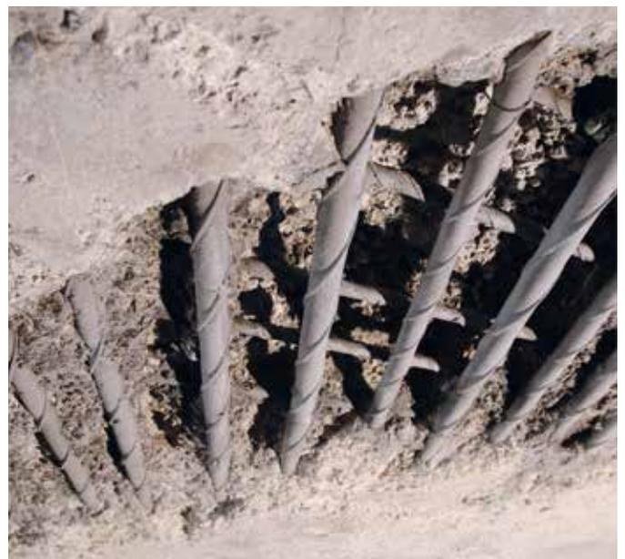
Bei sachgerechter Verarbeitung der Systemkomponenten, die in der Regel aus Armierungsschutz, Haftbrücken, Grobmörtel und Feinspachtelmassen bestehen, können auch bereits weit fortgeschrittene Schäden behoben bzw. durch Aufbringen präventiver Betonschutzbeschichtungen (Karbonatisierungsbremsen) das Auftreten von Schäden verzögert werden.
